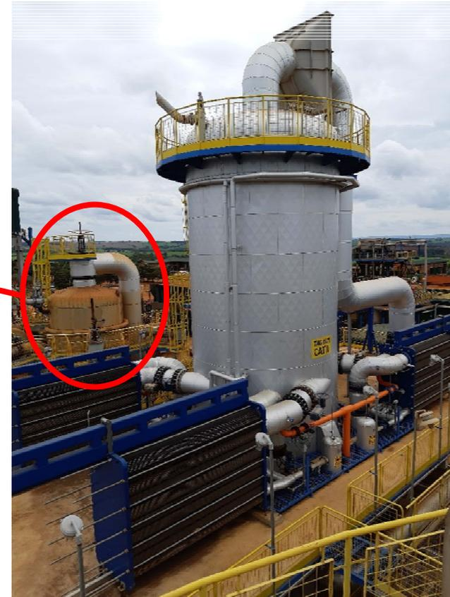
**Na Aroeira temos um reboiler operando em paralelo com o satélite a placas, alimentados pela mesma linha de VE e com a saída de V1 interligada**
