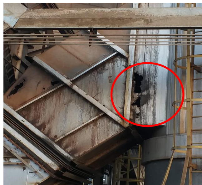
Falha em Sistema de Lavagem
