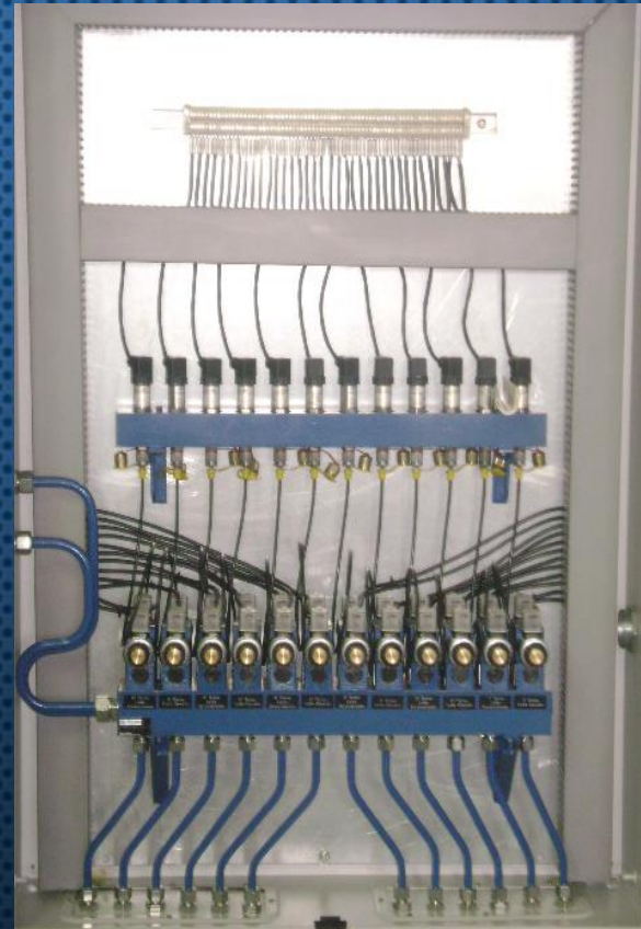
Painel de válvulas automáticas e transmissores de pressão.
