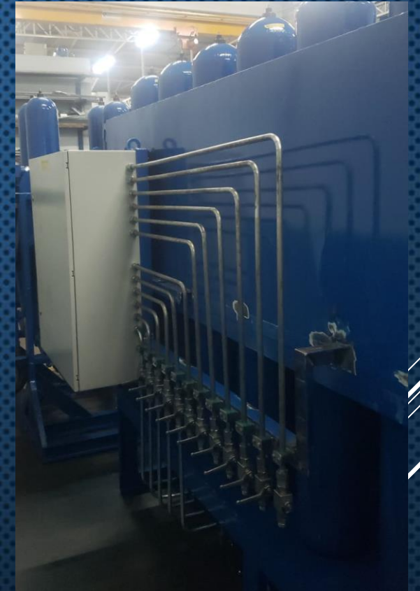
Painel de válvulas automáticas e transmissores de pressão.
